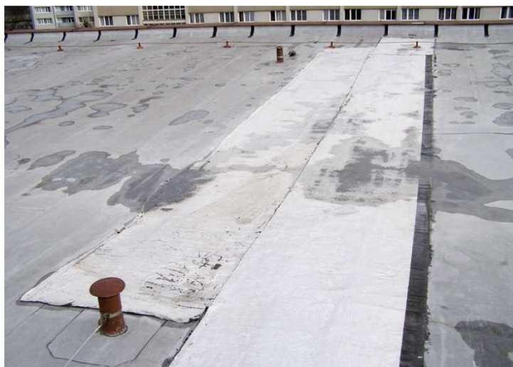
Pohled na povrch střechy A3, lokální oprava asfaltovými pásy
